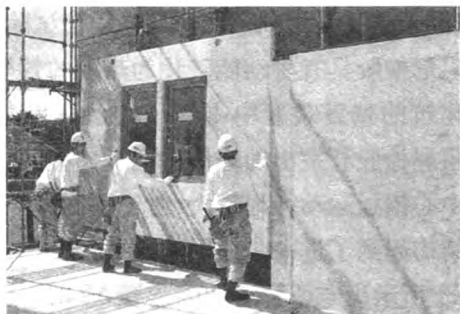
图 7 标准化施工现场
